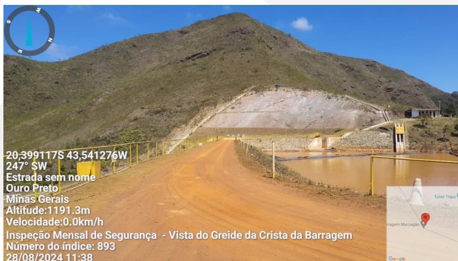
Foto: Crista da Barragem do Marzagão
