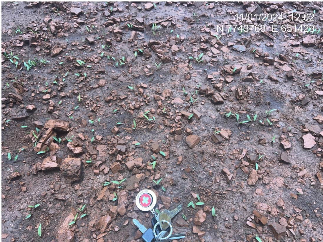
Figura 6.1 – Plantação de gramíneas diretamente sobre rejeito no reservatório da Barragem do Marzagão.
